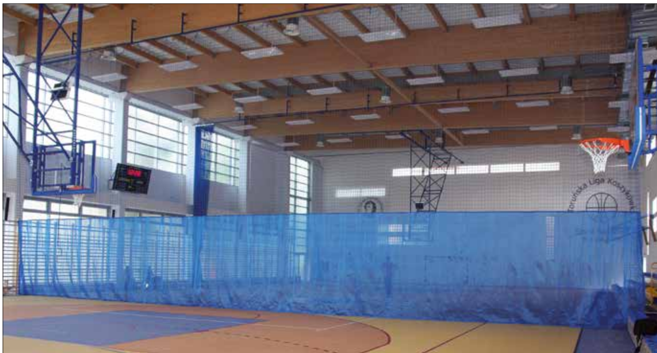
Układ jezdny kotary grodzącej z przesuwem ręcznym
